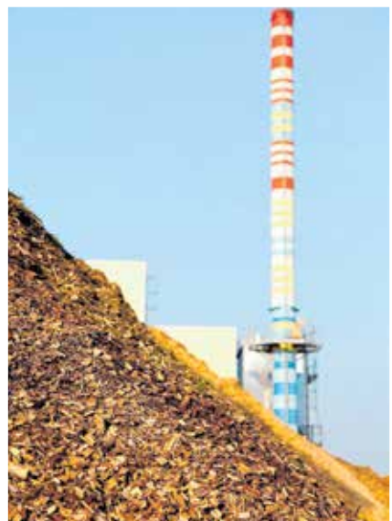
Blick auf das Biomasse-Heizkraftwerk. Foto: Roland Becker
